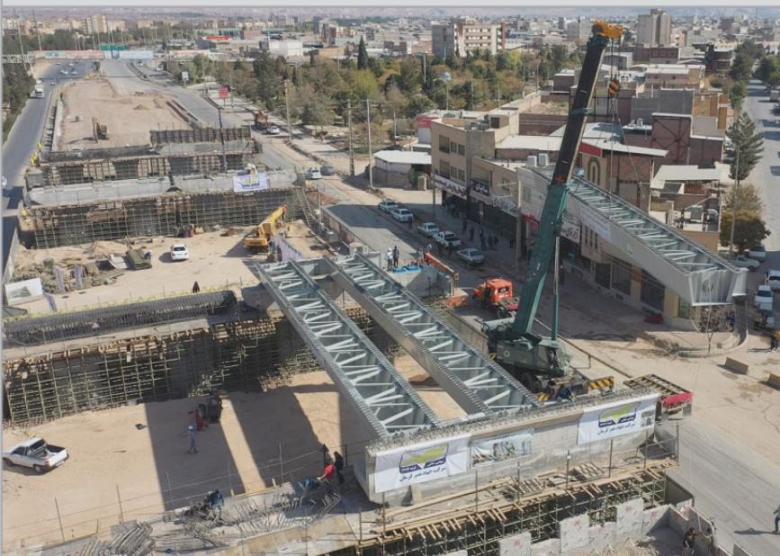
عملیات اجرایی و باوجود تاخیرات ناشی از معارض های تاسیساتی، تا کنون کل عملیات احداث شمع های عمیق به تعداد ۶۴ اصله و ساخت تمام فونداسیون ها و ستون ها انجام شده است که در نوع خود به جهت سرعت و کیفیت عملیات ساخت پل های بزرگ یک حد نصاب کم نظیر می باشد.
